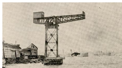
震災で倒れなかった50 トンハンマーヘッドク レーン
